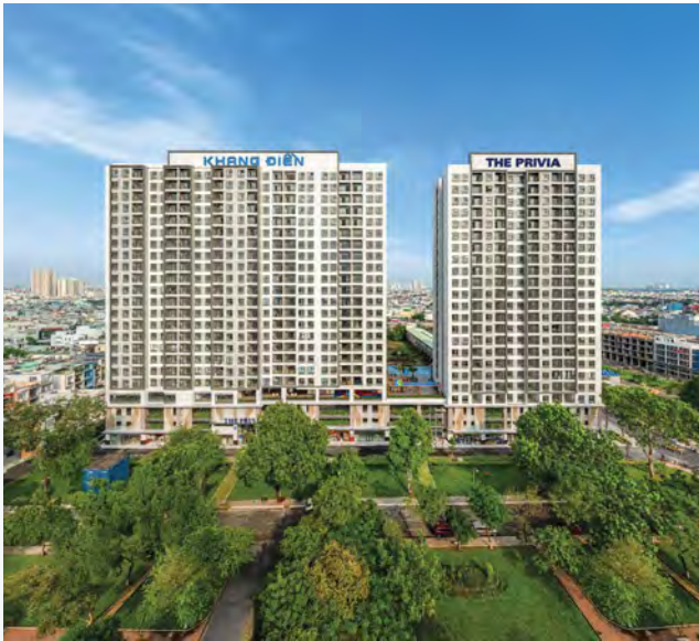
The Privia Project - Actual Photo
